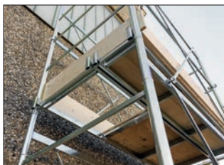
Piano di lavoro (0,84x1,67 m) in due pezzi, con botola; fermapiedi anticaduta oggetti.
