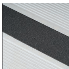
Ampi gradini con inserto antiscivolo: profondità 210 mm.
